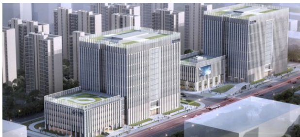
图1 中江智慧建筑产业园项目效果图
