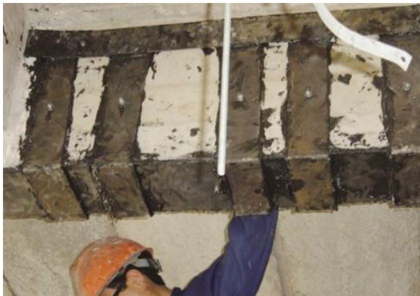
图1 碳纤维包裹混凝土
