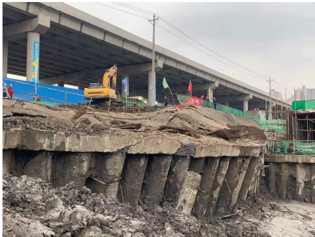
图3 基坑失稳图
