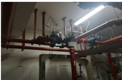
图3 泄压阀前阀门处于关闭状态
