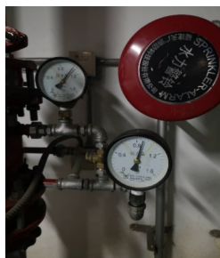
图1 湿式报警阀组前后压力差值过大
